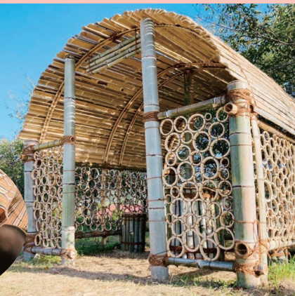
完成した竹のドーム
